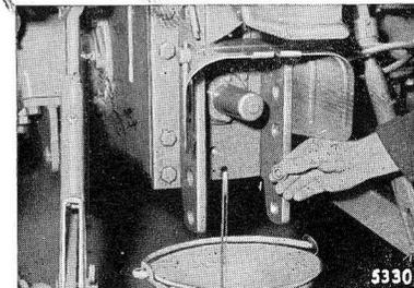
**Lenkung.** Kontrolle und Ergänzung der Ölmenge durch die oben auf dem Gehäuse vorgesehene Verschlussschraube bis zum Gewinde.
